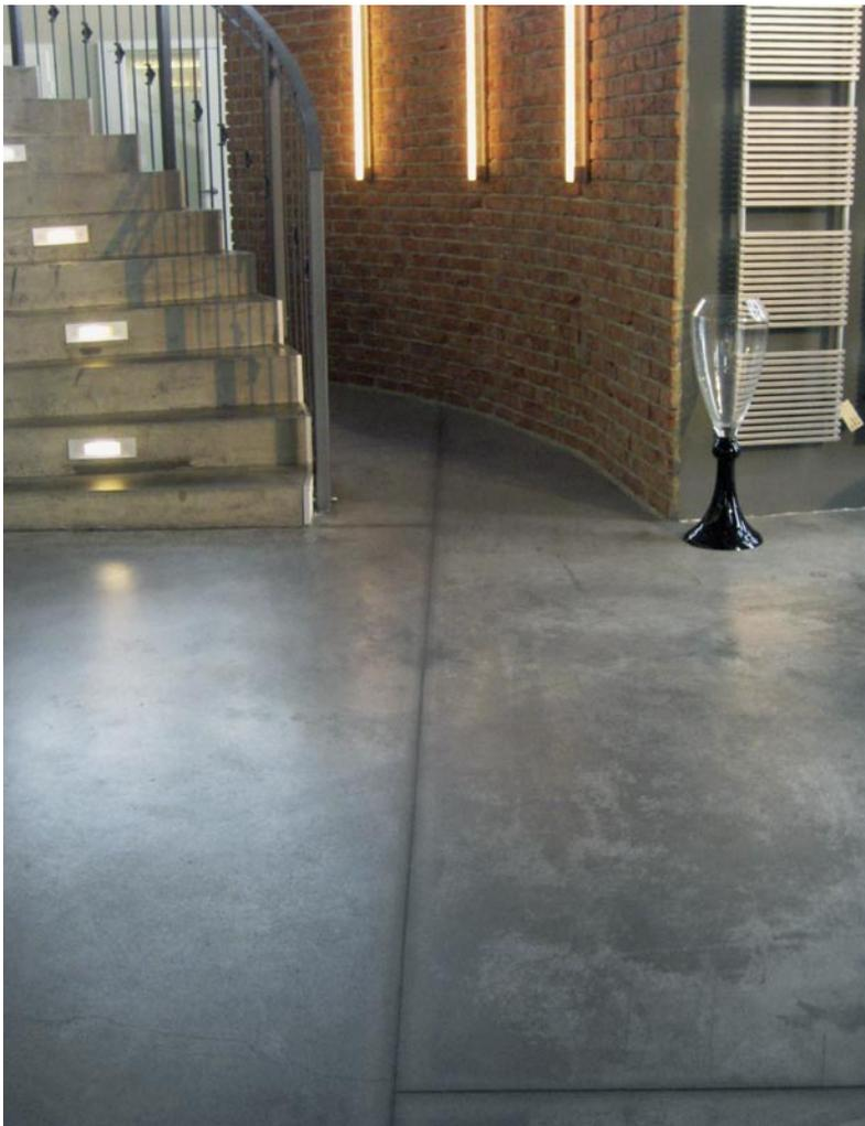
Bild 11: Optische Unterteilung der Fläche durch Scheinfugen
