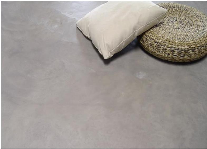
Bild 6: Wolkenartige Strukturen auf einem mit Schleiertechnik veredelten Zementestrich
