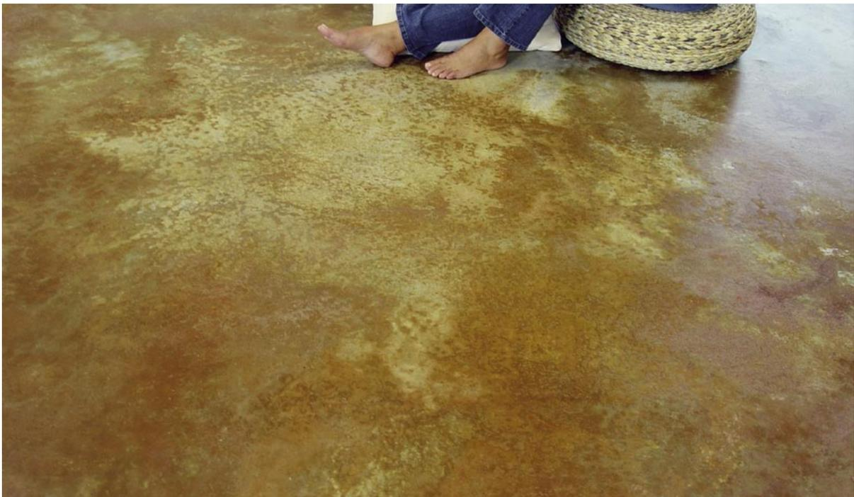
*Bild 1: Jeder Boden ist ein Unikat – hier ein gebeizter Zementestrich mit einer sehr warmen Ausstrahlung*
