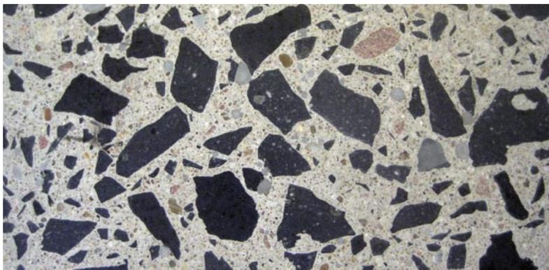
Bild 13: In diesem geschliffenen Zementestrich sind die verschiedenen Farben der Gesteinskörnung gut zu erkennen.
