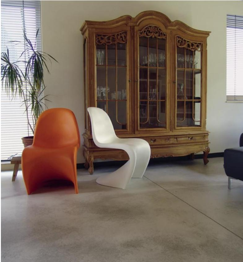
Bild 2: Pigmentierter Zementestrich in einem Wohnraum
