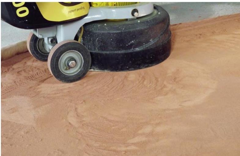
Bild 8: Bodenschleifmaschine auf Sand-Zementestrich
