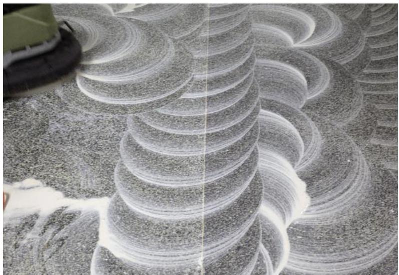
Bild 10: Abschließende Einpflege eines geschliffenen Estrichs
