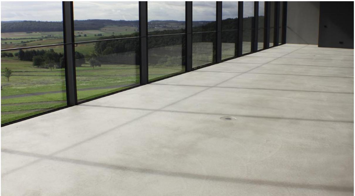
Bild 3: Für stark genutzte Bereiche bieten sich Zementestriche an, da sie widerstandsfähig und schmutzunempfindlich sind.
