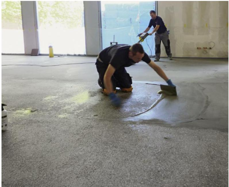
Bild 9: Spachtelarbeiten nach dem Grobschliff
