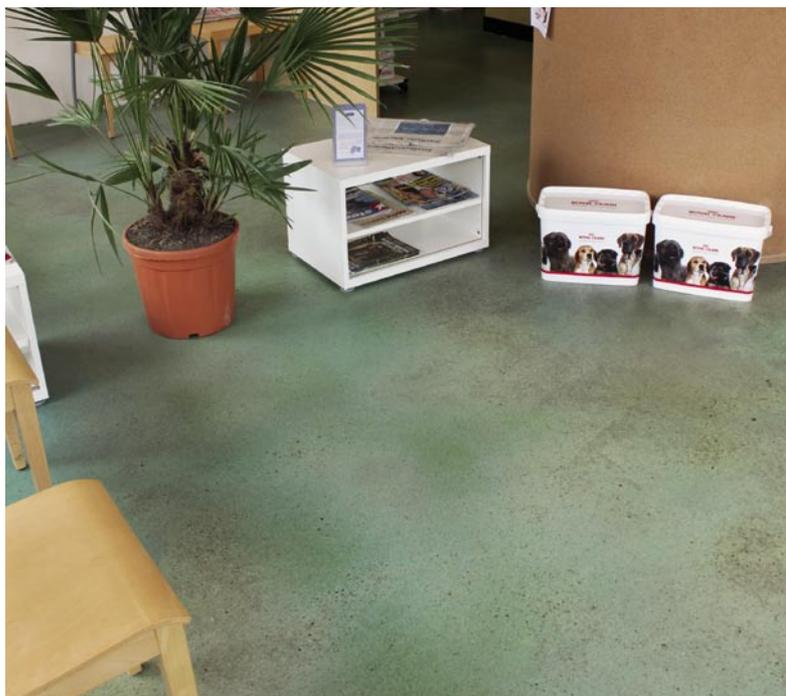
*Bild 8: Mit Beiztechnik bearbeiteter Zementestrich, der gleich mehrere Farben enthält.*
