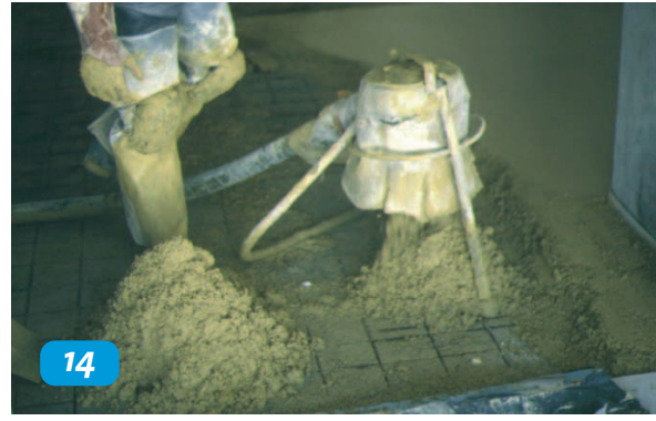
Einbringen eines gelben Estrichs
