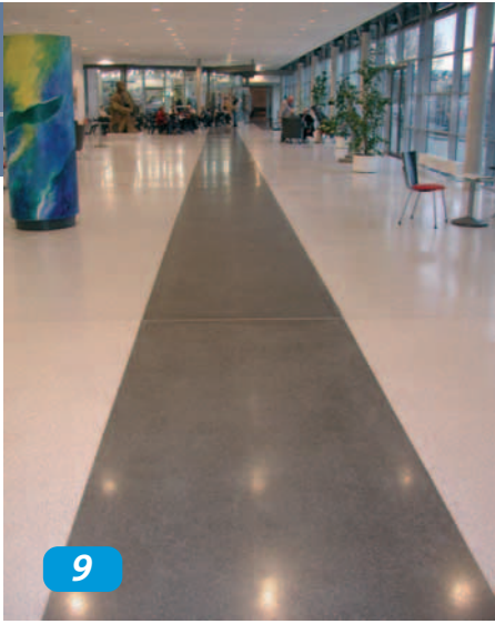
Feingeschliffener Estrich im Krankenhaus Ehingen
