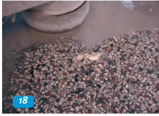
Naßschleifen eines Terrazzobodens
