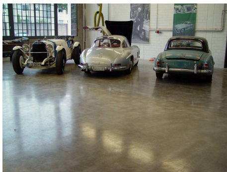
Die direkte Nutzung von zementgebundenen Estrichen und Betonböden erfreut sich im Gewerbebau zunehmender Beliebtheit (Bild: Gorlo Industrieböden, Bielefeld)
