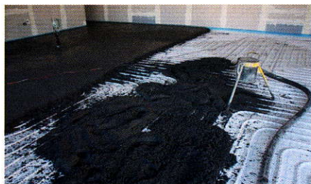
Die Mörtelkonsistenz ist weichplastisch bis erdfeucht.
