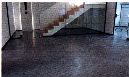
Durch die maschinelle Glättung wird eine oberflächennahe Verdichtung erzielt.
