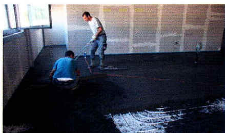
Innerhalb der Verarbeitungszeit von ca. 60 Min. muss die Oberfläche geschleibt und geglättet werden.
